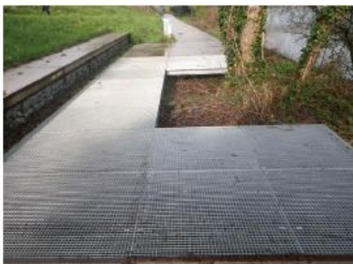
Le tracé contourne un bosquet d'arbres, une zone en caillebotis pour préserver le système racinaire
