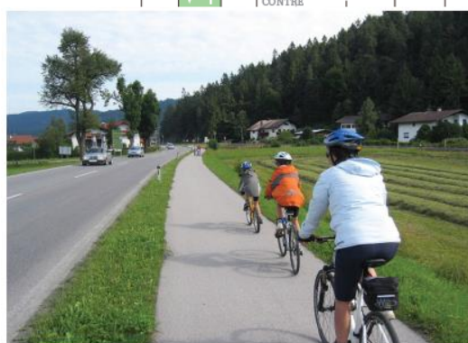
Piste cyclable séparée de la par une bande enherbée
