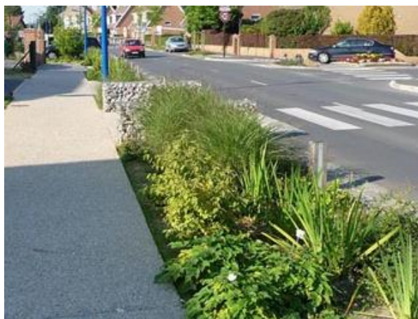
Piste cyclable sécurisée et passage piéton
