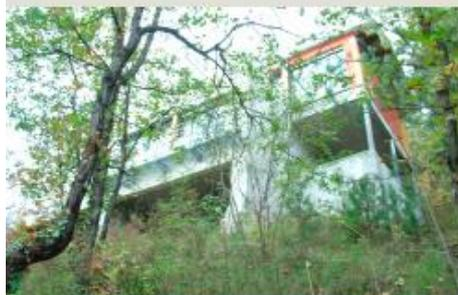
→ Sur ce terrain à pente «extrême» où le rocher est affleurant, la solution de se surélever du sol s'est imposée au concepteur. La maison développe ses niveaux en cascade, ce qui permet la réalisation d'une grande terrasse accessible qui compense la difficulté d'utilisation du terrain. Un espace «sanitaire» a été créé entre la maison et le rocher pour limiter les infiltrations des eaux de ruissellement.
