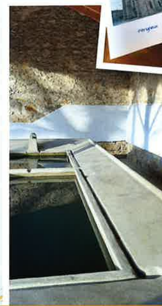
Remise en état du bandeau du lavoir de la Conche
